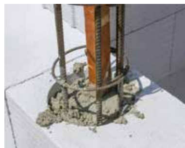
Betonujeme a hutníme postupně se zděním, nejlépe vždy po položení tří vrstev zdiva.
