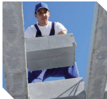
Ukládání stropních vložek
