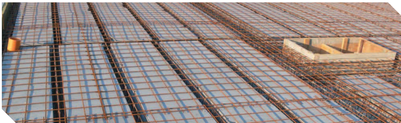
Vyskládaný a vyarmovaný strop před betonáží
