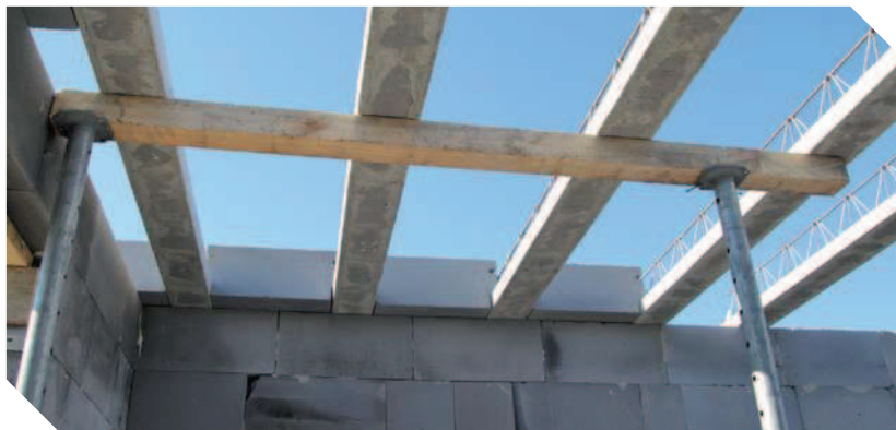
Podepření stropních nosníků
