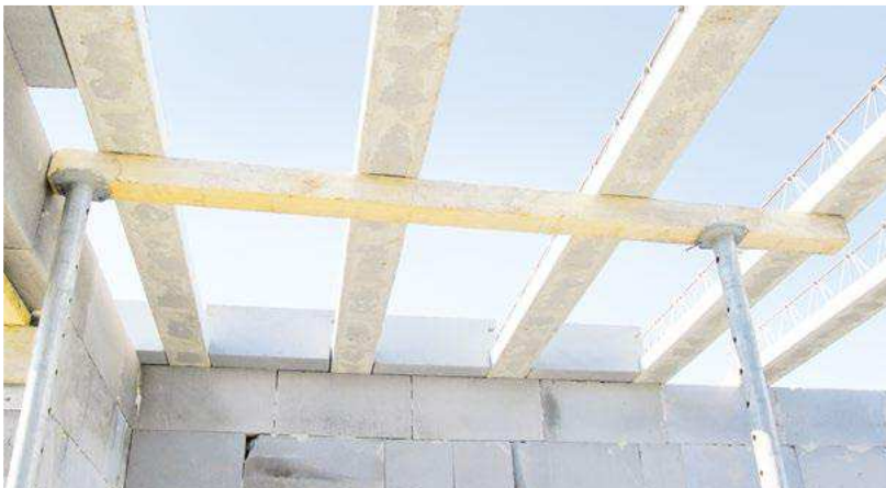
Podpěření stropních nosníků
