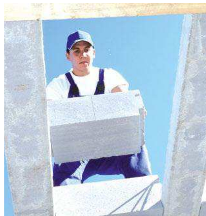
Ukládání stropních vložek
